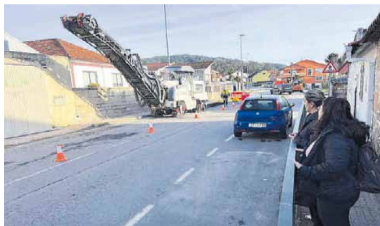
La alcaldesa y la concejala de obras, observando ayer la ejecución de los trabajos. | Santos Álvarez
