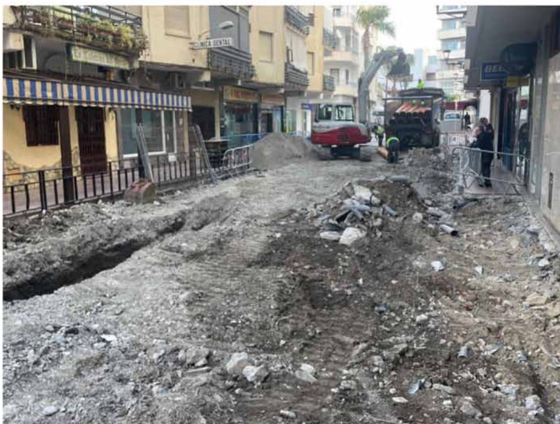
Obras en la Calle Granada de Almuñécar
