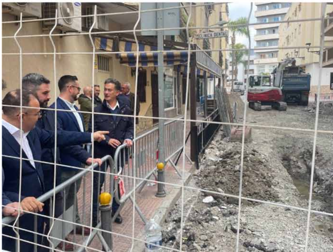
La calle Granada de Almuñécar renueva sus redes hidráulicas gracias a la Mancomunidad de la Costa Tropical
