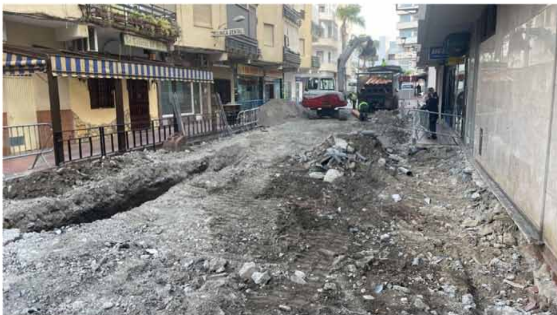
Obras en Almuñécar (MANCOMUNIDAD)
