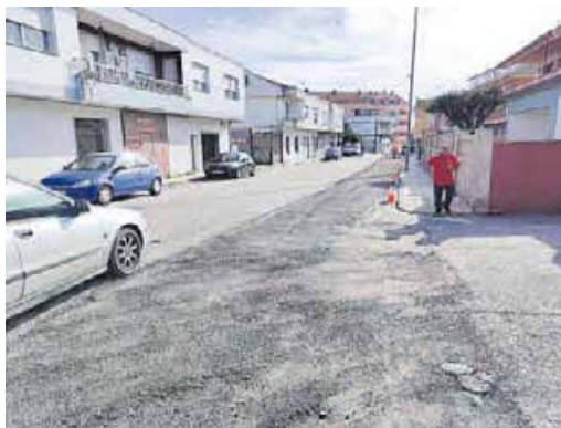
El material fresado se ha vuelto a compactar. | Santos Álvarez
