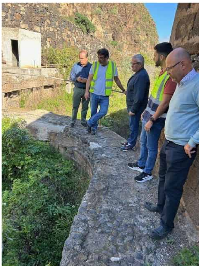
Visita a los trabajos de renovación de la red de saneamiento de Las Boticarias
