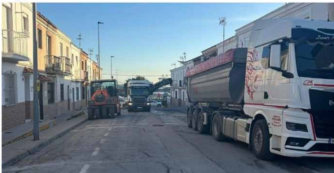
Trabajos en la zona. / FOTO: AAM
